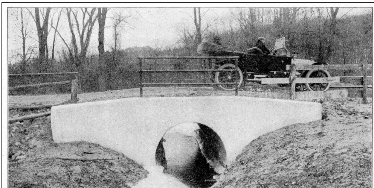
BRIDGE "C," BOW BROOK, BOW, N. H.
